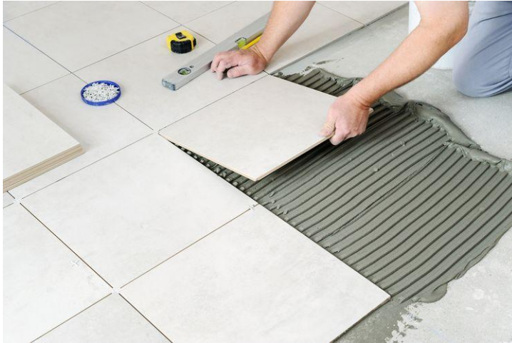
Sumber : lifestyle.compas.com Gambar 3.3 pemasangan ubin
